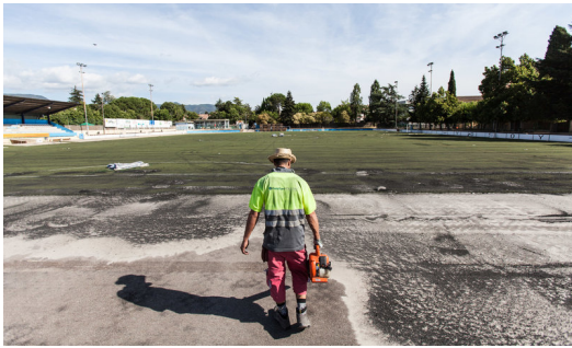
Una imatge dels treballs de substitució de la gespa artificial de Santa Coloma, fa uns dies Foto: DAVID RUEDA / AJ. DE STA COLOMA.
