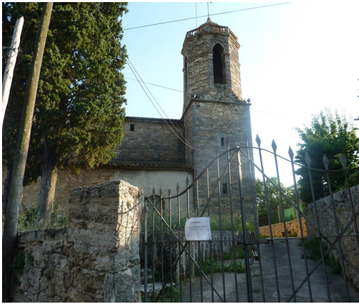
Una vista de l'església del Remei de Guèmol, amb el mur on s'han dut a terme els treballs en primer terme Foto: J.C.
