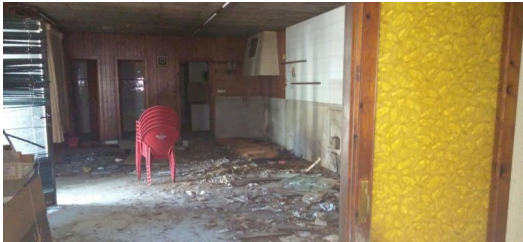
Una imatge de l'interior del bar Manix de Sils, que serà derrocat a partir de dilluns Foto: EPA.
