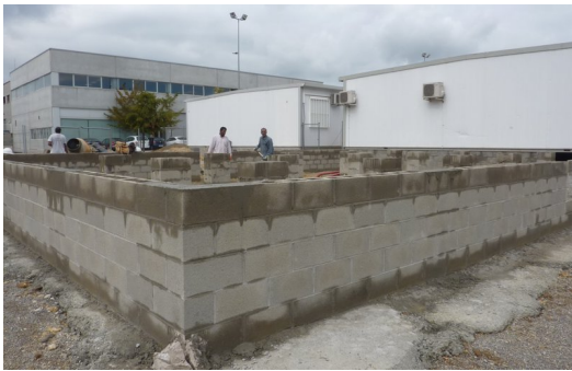
Les obres per a instal·lar el nou barracó, a principis de la setmana passada. Foto: R. E.
