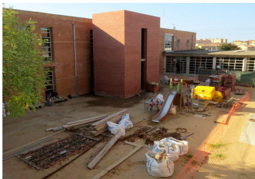
El pati tancat de l'escola Quatre Vents, en un moment de les obres. Foto: AJUNTAMENT DE BLANES.
