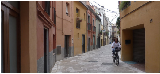
El nou aspecte del carrer dels Valls, aquesta setmana, un cop finalitzats els treballs. Foto: R. E.
