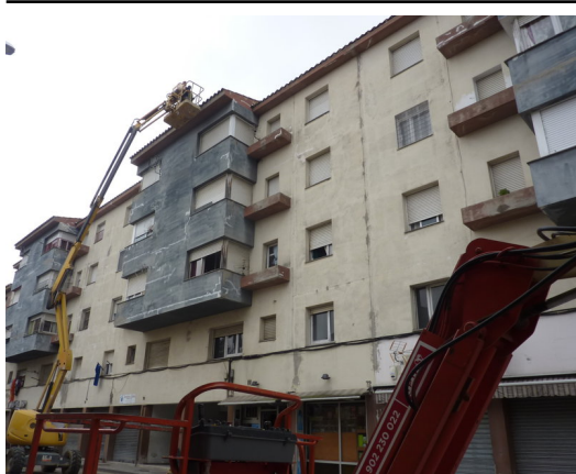
Les obres es concentraven aquesta setmana en unes façanes d'edificis situats al carrer Barcelona. Foto: R. E.
