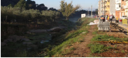
Les obres que han començat al tram del carrer Oslo
