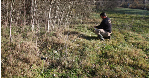
La instal·lació d'una tanca electrificada
