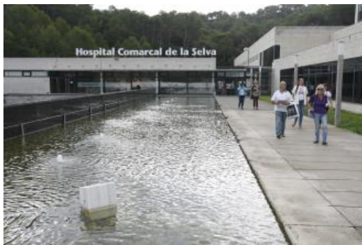
Hospital Comarcal de Blanes
