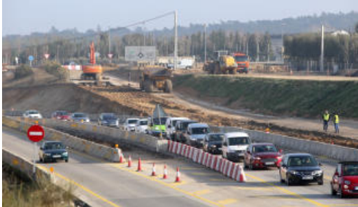
Cues a la N-II per les obres de desdoblament a Vidreres
