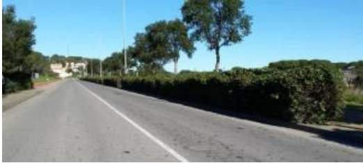
El tram de la ronda de l'Est afectat pel projecte d'asfaltatge.
