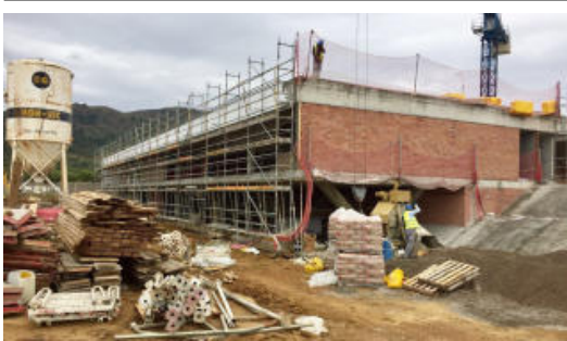
Obres escola Montserrat Vayreda
