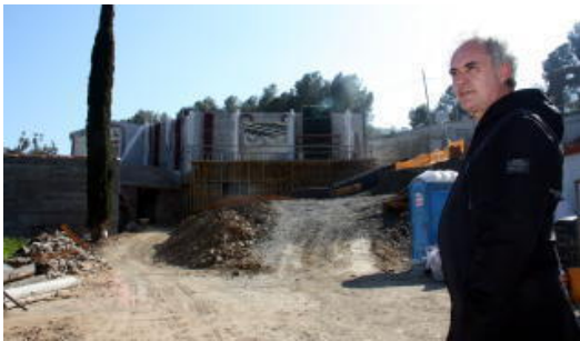
Obres d'ampliació del nou Bulli
