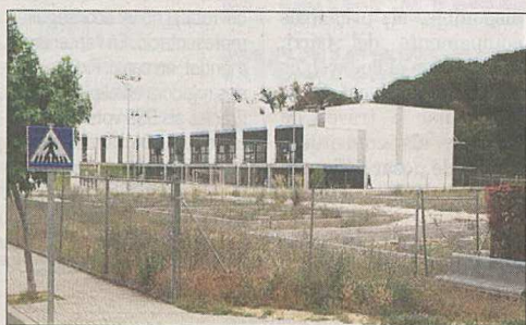
El nou institut de Caldes es construirà just al costat de l'escola de la Benaula (al fons) ■ JOAN SABATER
