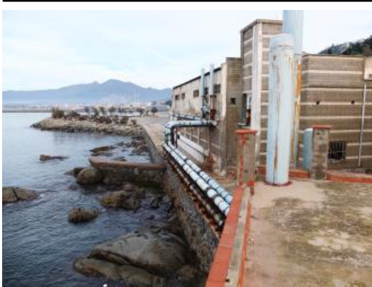
L'antiga depuradora de marisc de Roses
