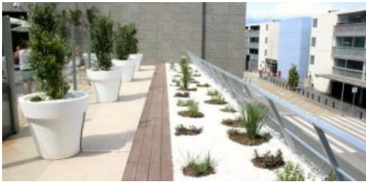
L'aeroport renova la terrassa
