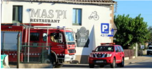
Els Bombers treballant a la fuga de gas
