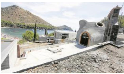
Obres del nou Bulli 1846
