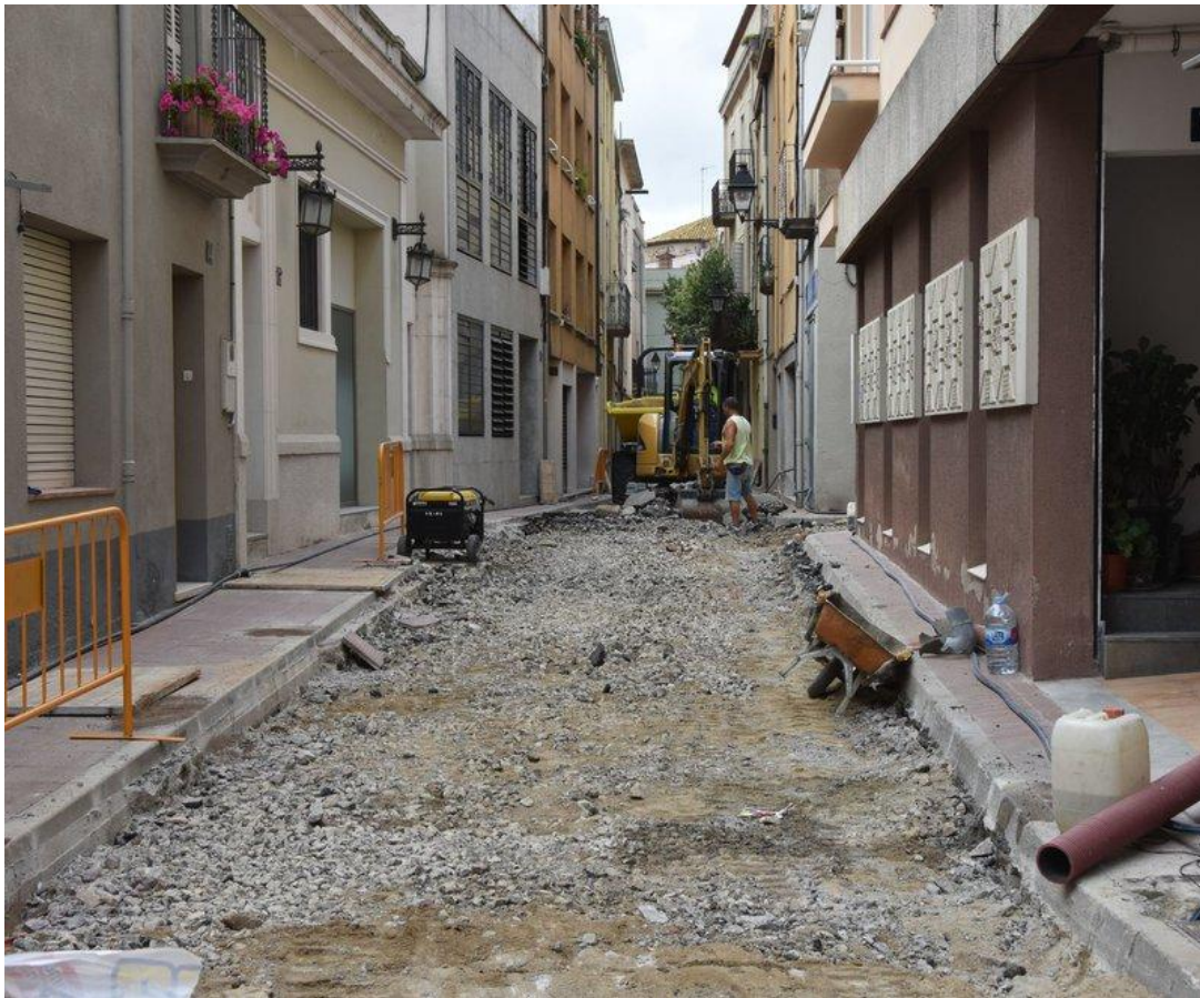
Un carrer del nucli històric de Cassà de la Selva que ja està en obres des de principis d'aquesta setmana Foto: AJUNTAMENT DE CASSÀ DE LA SELVA.
