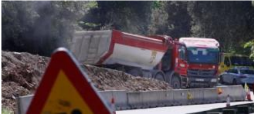
Un senyal adverteix de les obres al tram de la Pilastra.
