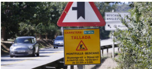
Primera nit de talls nocturns de trànsit a la «carretera de la Vergonya»
