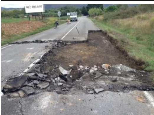
Treballs d'asfaltat a la ronda de Roses.
