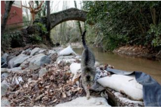
La resclosa del Molí de les Pipes està feta amb sacs de sorra.
