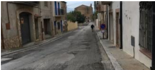
Carrers que s'estan asfaltant.
