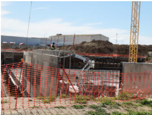
Les obres de la depuradora
