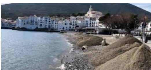
Els treballs de reparació.
