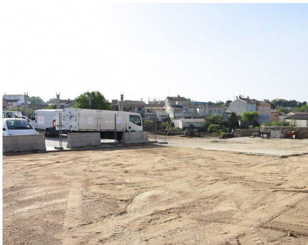
Les obres de l'ampliació del carrer Marina. Foto: AJUNTAMENT CASSÀ DE LA SELVA
