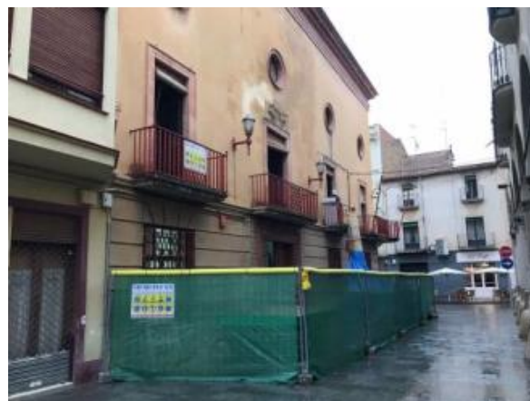
Cinc municipis gironins tenen pròrroga per acabar les obres del
