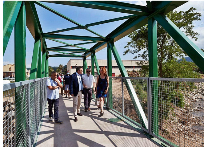
El nou pont de la riera d'Osor durant la inauguració. diputació
