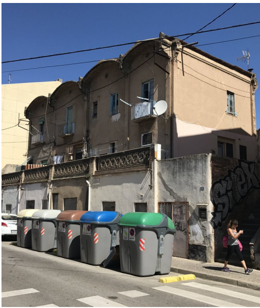
Els edificis que s'enderrocaran, en una imatge d'arxiu de l'any 2017 JORDI NADAL.
