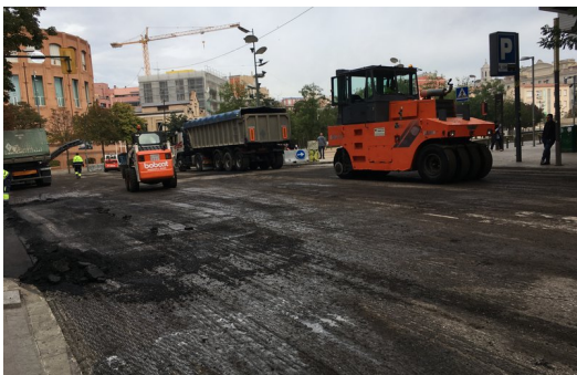
Obres de reasfaltatge a la Gran Via de Jaume I, l'octubre del 2019 Ò. PINILLA.
