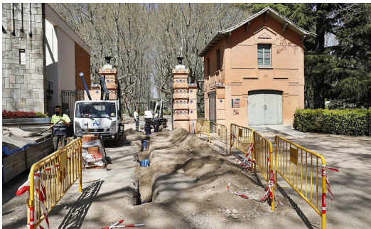
Una de les rases per canviar la canonada i que arribava fins als jardins de la Devesa del parc.
