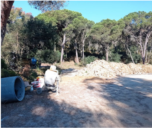
Material de construcció i acumulació de terra a la zona denunciada per Salvem El Crit CEDIDA.
