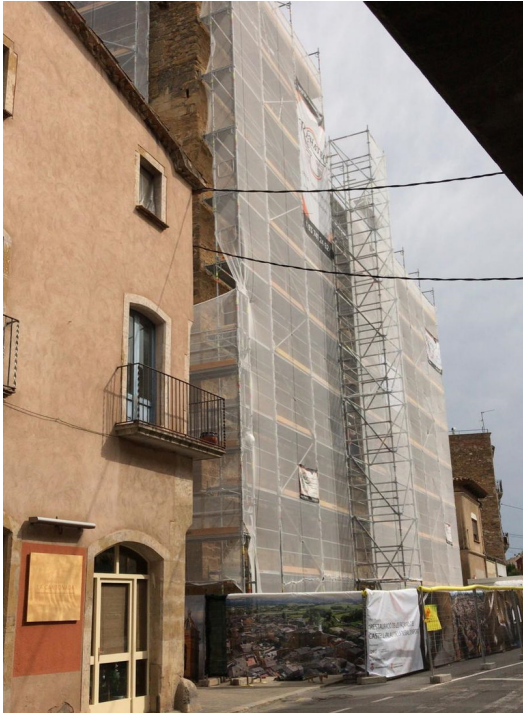
Una imponent bastida amagarà durant els treballs de rehabilitació la façana del castell palau de la Bisbal J.T.
