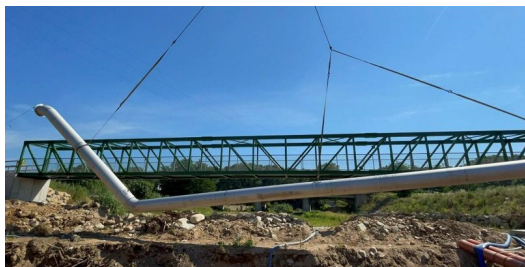
El tram de canonada que s'ha substituït al pont de la riera d'Osor entre Anglès i la Celler de Ter AJ. DE GIRONA.
