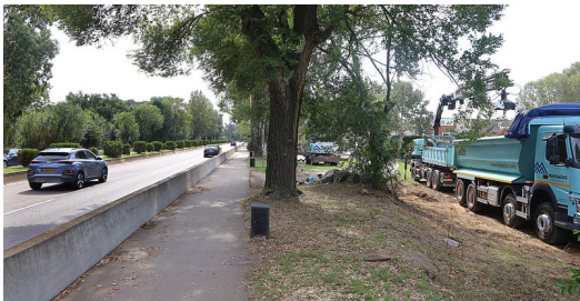
Les obres, aquesta setmana, per fer el carril paral·lel a l'autovia GIV-6546 MANEL LLADÓ.
