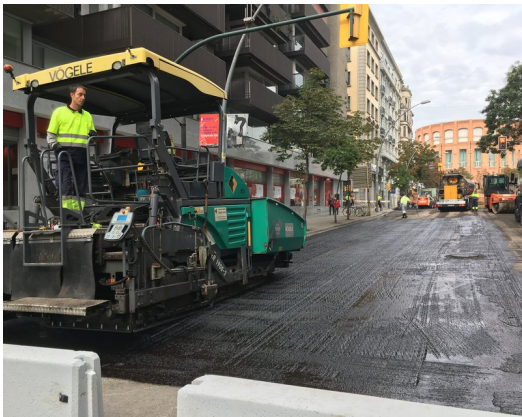
Màquines asfaltant la Gran Via de Jaume I, en una imatge d'arxiu O.P.
