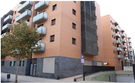
Els baixos de l'edifici –avui sense ús i tapiats– seran la seu de l'Espai LGTBI MANEL LLADÓ.
