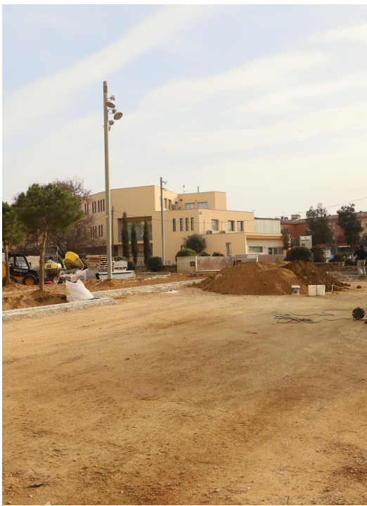
Les obres, a l'esplanada que separa la seu de la policia local del Centre Municipal d'Educació E.A.
