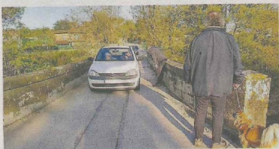
Vianants i vehicles circulant pel pont de Can Solà. PLATAFORMA CALDENÇA
