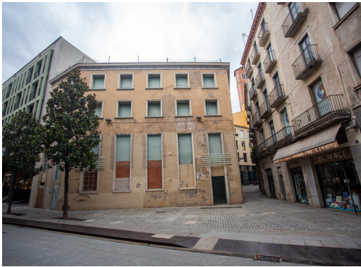
L'exterior de la central del Molí, al carrer Santa Clara, a l'agost del 2021. QUIM PUIG.
