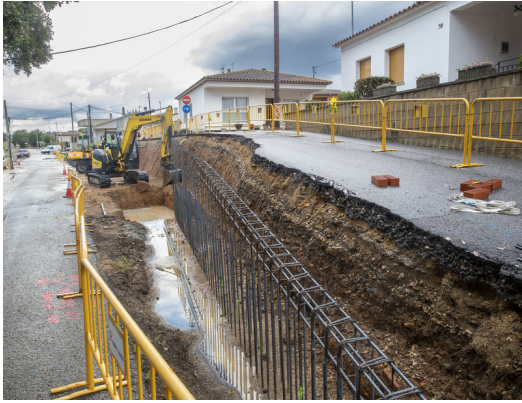
Les obres d'urbanització a Riudellots AJ. RIUDELLOTS.
