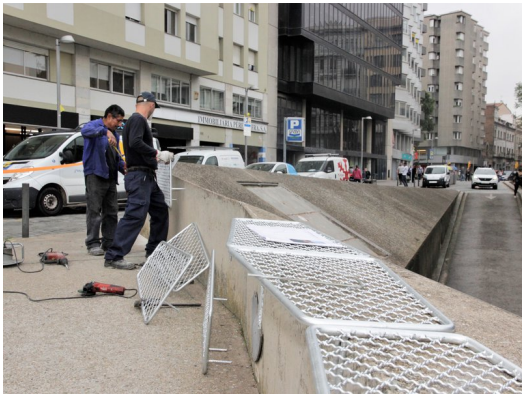
Instal·lació de tanques de protecció a la plaça AJUNTAMENT DE GIRONA.
