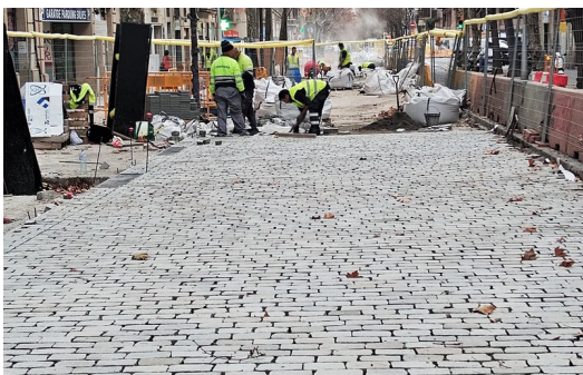
Tres operaris treballen en l'encatifat de llambordes del tram central del carrer de Girona, entre els d'Aragó i València JPF.
