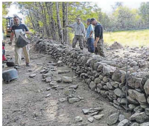
Una de les sessions de formació de construcció de murs de pedra seca
