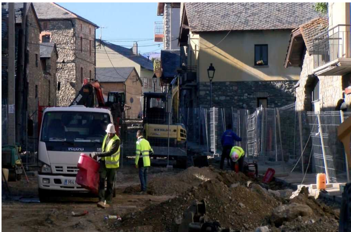
Obres al carrer del Nord d'Alp / M.A.M.
