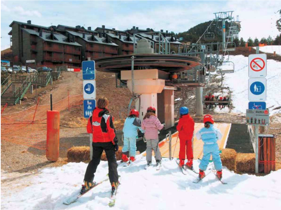
El telecadira de Font Canaleta es va instal·lar l'any 2005 (Foto: Poma).
