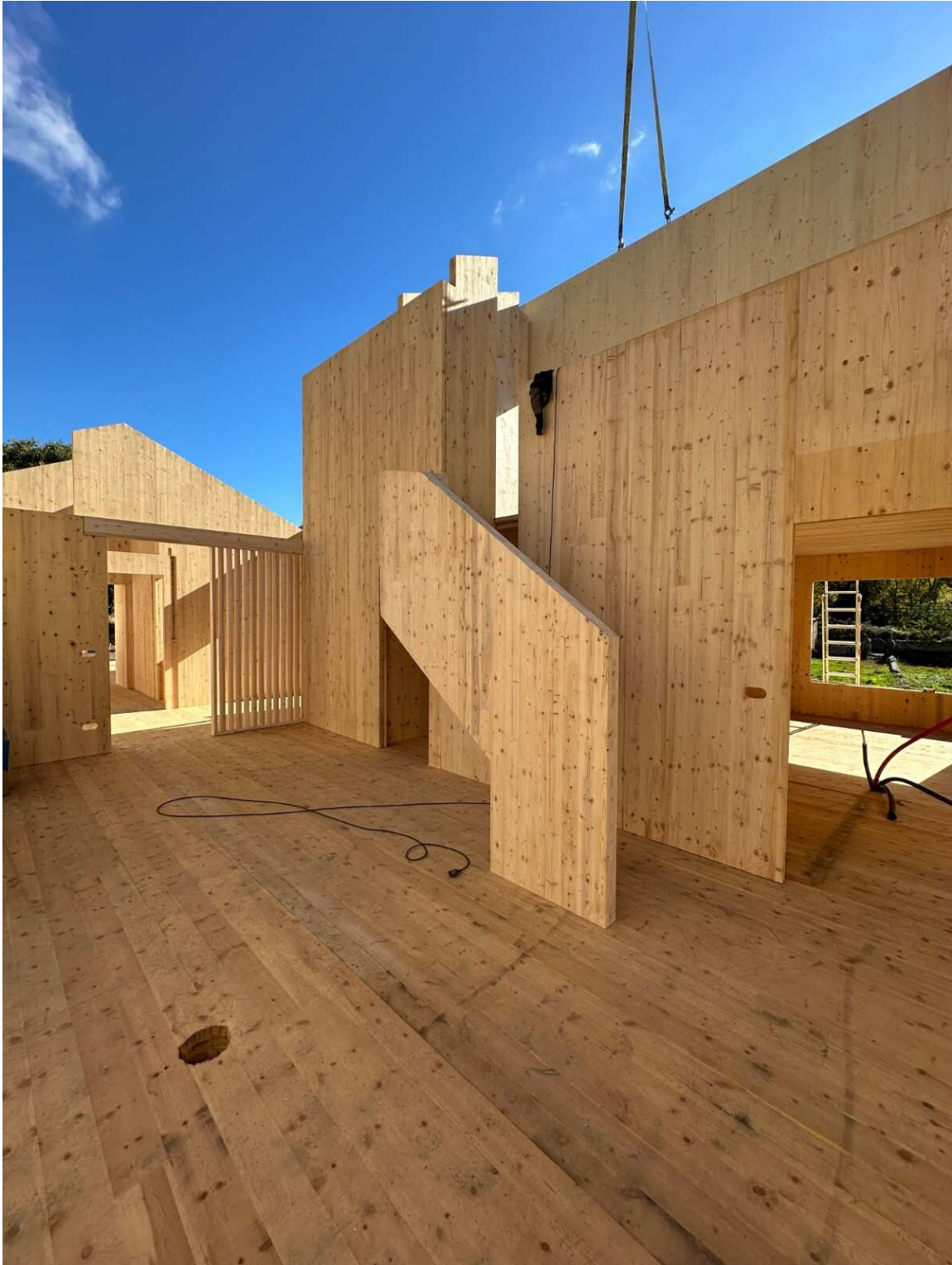
Estructura d'una casa de fusta laminada encreuada (CLT). Fustes Sebastia SL.
