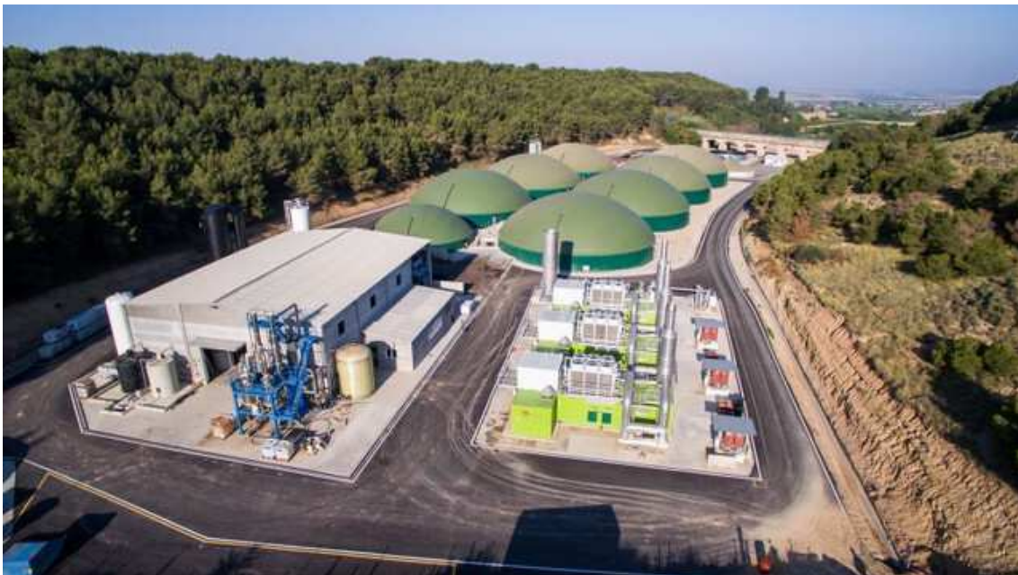
Planta de biogàs del Grup Griño que impulsa la descarbonització i l'economia circular. Bioenergia d'Almenar S.L.
