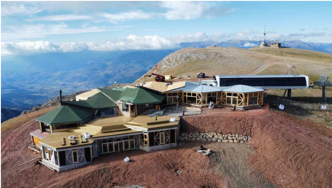
Estat de les obres del refugi del niu de l'Àguila / @FGCcorporatiu
